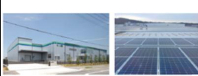
伊藤園神戸工場での太陽光パネルの設置 (2023年1月)
