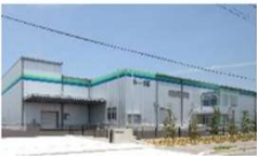
伊藤園 神戸工場 (2023年1月設置)
